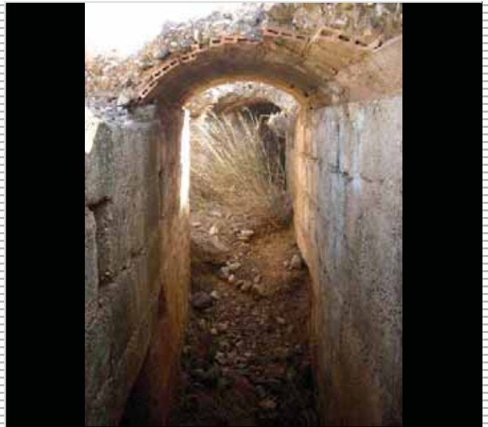
4. Trinchera reforzada con hormigón
