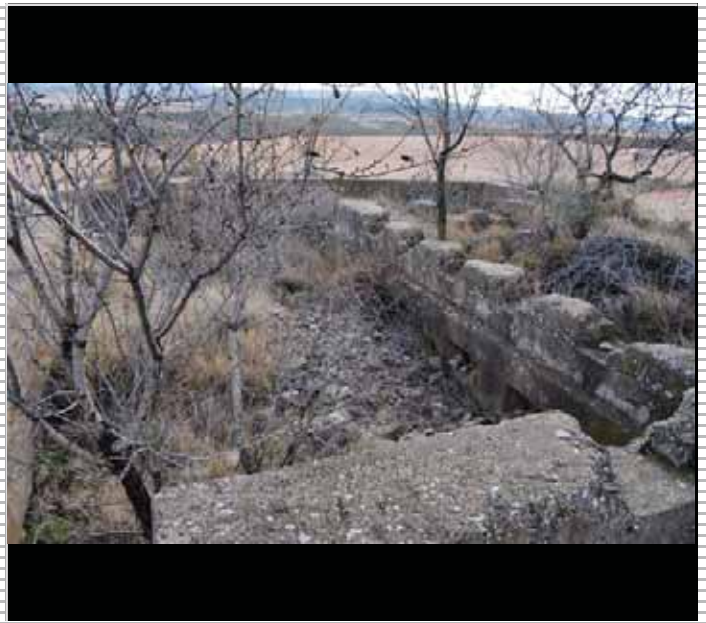
2. Vista estructura Bunker. Posición 4.
