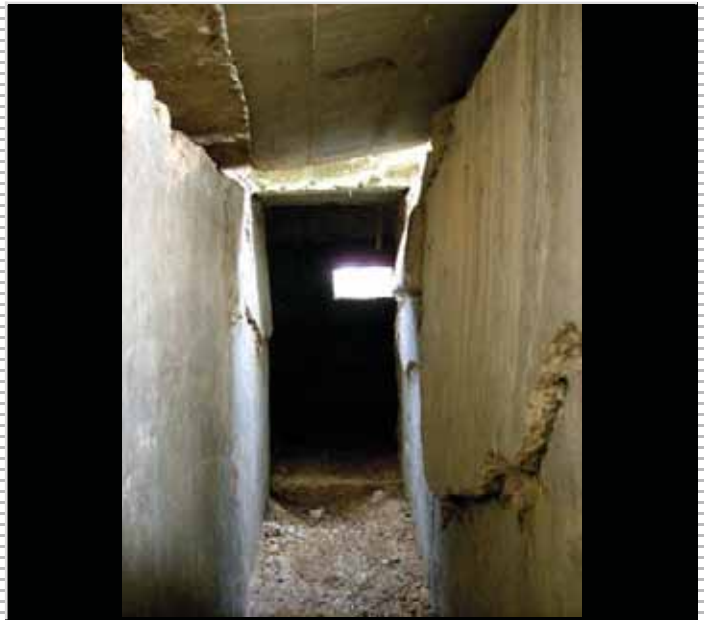
4. Interior de un nido ametralladoras.
