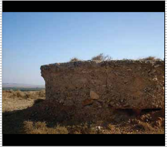
2. Restos de Búnker
