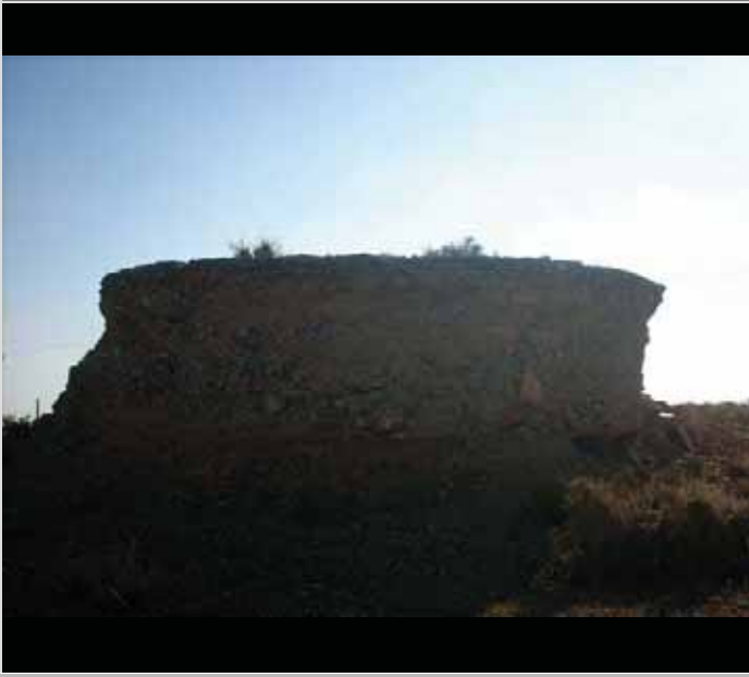
1. Restos de Búnker
