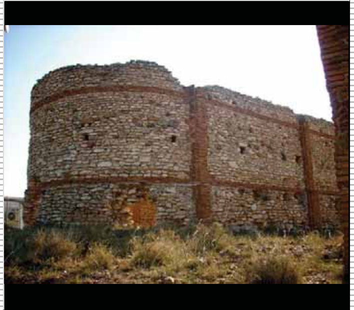
4. Edificio religioso de El Saso.
