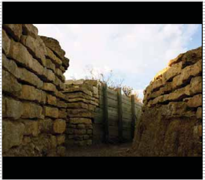
2. Detalle de trinchera.
