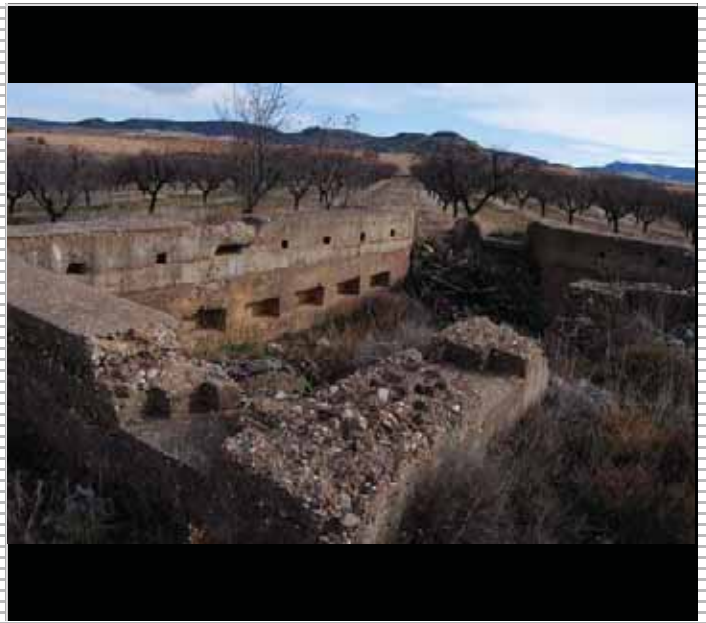
2. Vista Bunker. Posición 2
