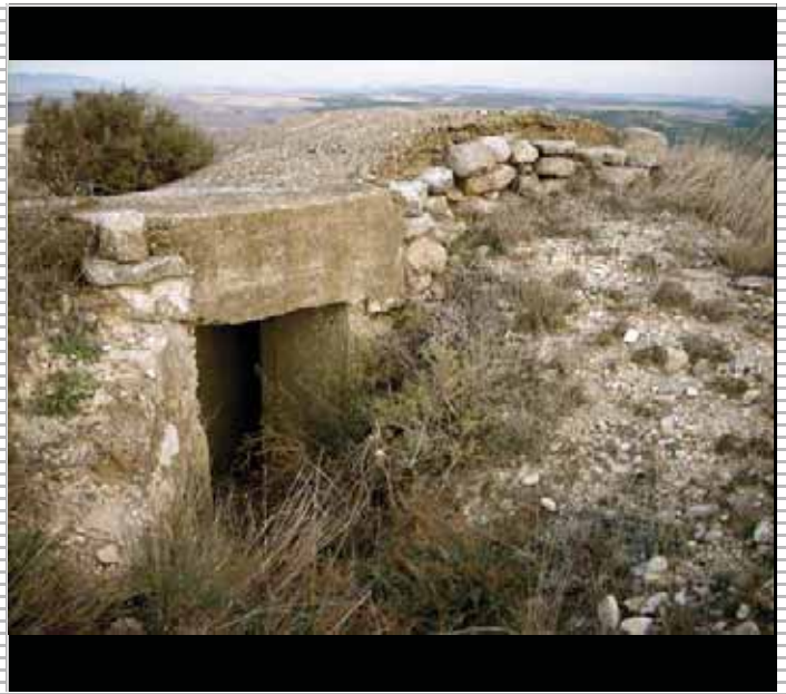
2. Entrada nido de ametralladoras.
