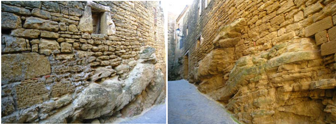
Casa construida integrando el saliente de la roca en la fachada en Orés.
