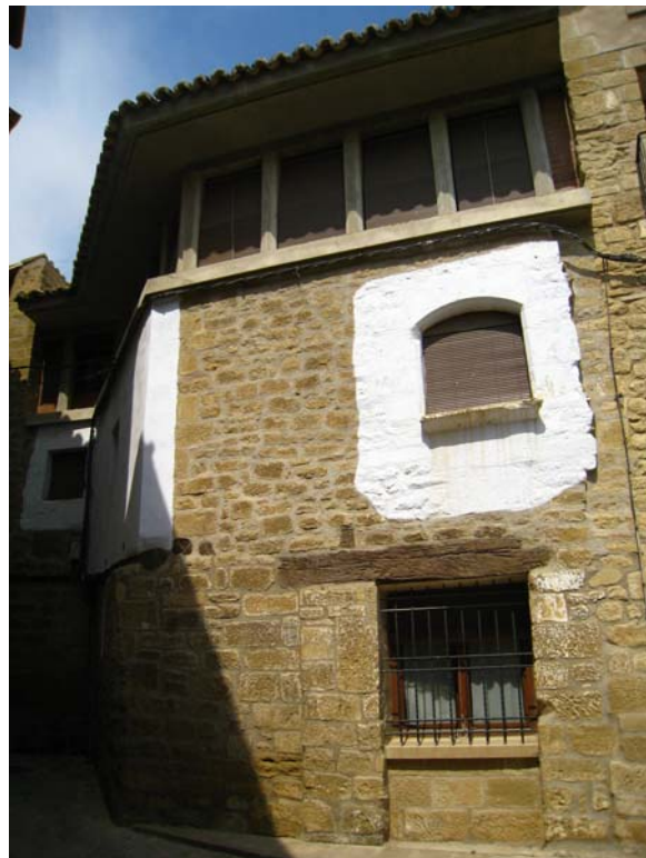
En los edificios de piedra, el encalado se limitaba a los vanos. Uncastillo
