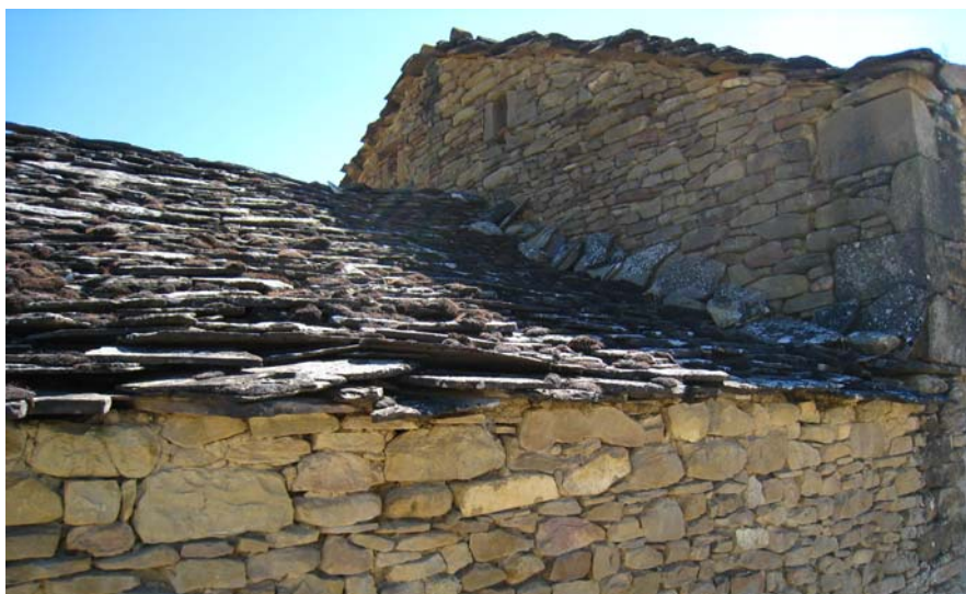
Tejado de losa en Undués Pintano (Los Pintanos)
