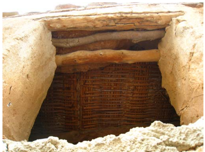
La estructura de cañizo constituye el techo en este edificio de Almonacid de la Cuba
