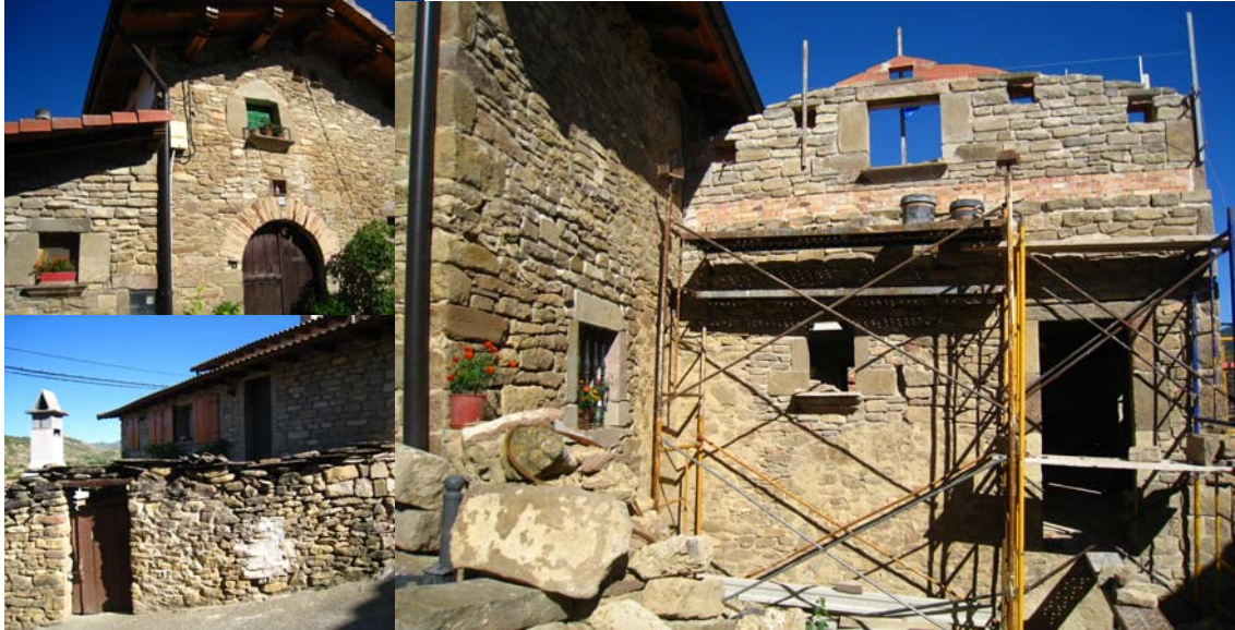
Casas rehabilitadas y en construcción a partir de las piedras que proporciona el entorno en Undués-Pintano (Los Pintanos)
