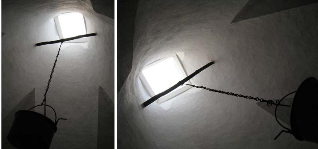
Chimenea convertida en óculo en la Casa Pedrobon en Salvatierra de Escá
