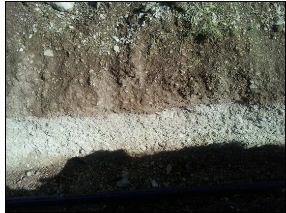
Detalle del nivel más carbonatado y suelo de labor
