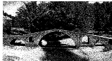
Puente romano en Luca de Jiloca.
