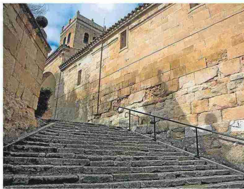
Escaleras de la Purísima Concepción. J. M.
