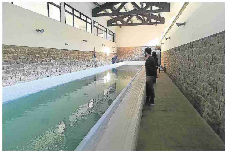
Estado en el que se encuentra el antiguo lavadero de Sádaba tras la actuación. N.B.
