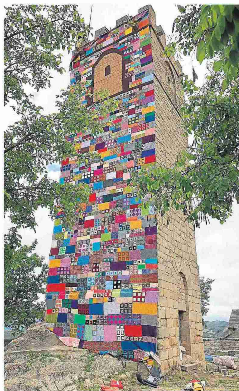
Los trabajos de montaje en la torre finalizan hoy. RUTA DEL TIEMPO
