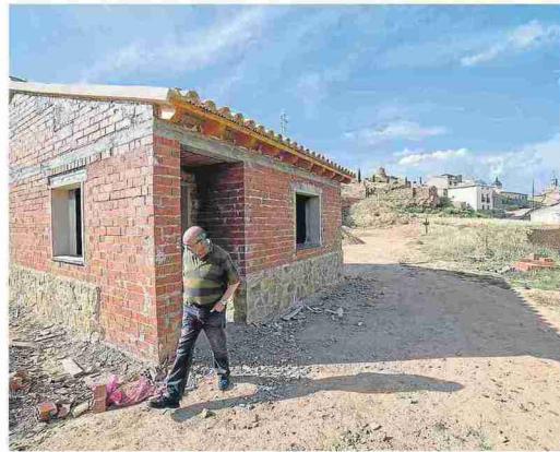
La nueva edificación ya está prácticamente acabada. MACIPE
