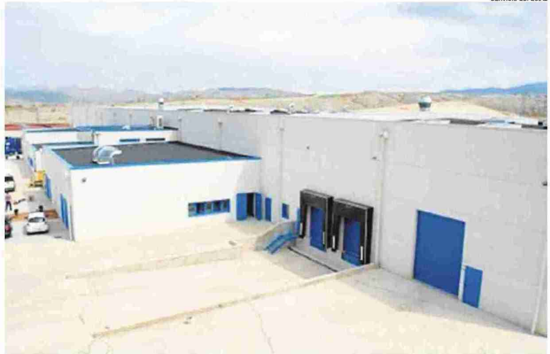
Instalaciones. El cuidado del medio ambiente ha primado en la construcción de la planta de AMD.
