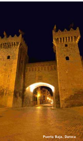
Puerta Baja. Daroca
