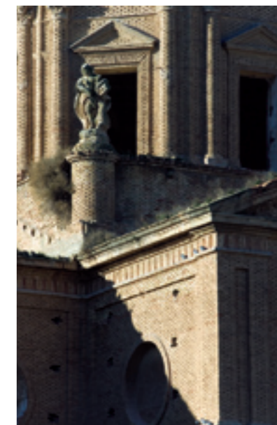
Détail. Monastère de Santa Fe Dettaglio. Monastero de Santa Fe
