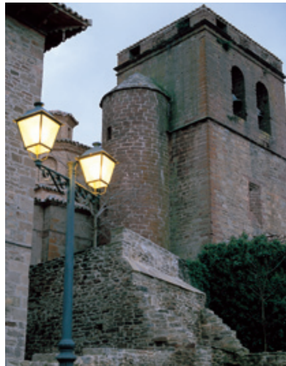
Church. Undués de Lerda Kirche. Undués de Lerda
