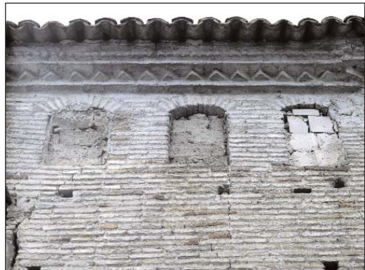
Alero y ventanas ocluidas de un hipotético edificio público de la judería, muy próximo a la ermita de San Bartolomé.
