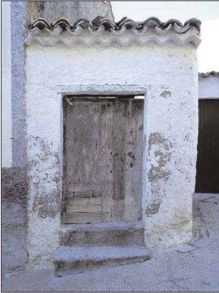
Acceso a una vivienda humilde de la judería. Calle de Pedro IV.
