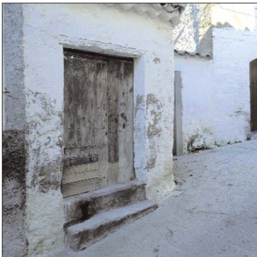
En las casas de las clases más modestas predomina el ladrillo con enlucido de cal. Calle de Pedro IV.
