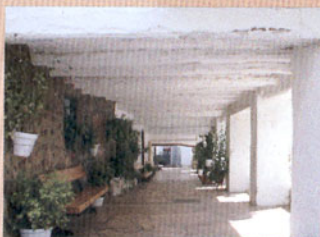
Pórtico de la Plaza Mayor.
