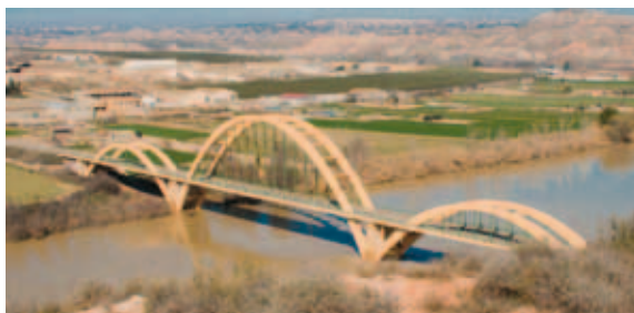
Puente de hierro sobre el Ebro, Sástago
