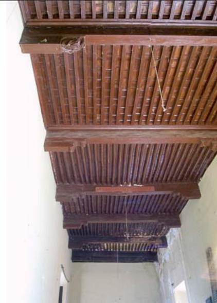
Techumbre del castillo y detalle de una de sus vigas.
