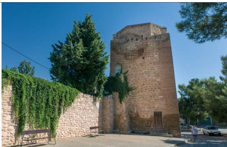
La torre gótica de la parroquia, de aspecto levantino, se muestra contundente. Arriba, Torreón de las Monjas y muralla.
