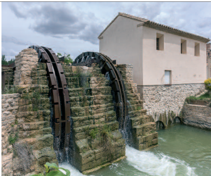
Las norias y el molino de Velilla dan fe del aprovechamiento de las aguas que históricamente se ha hecho en esta zona.
