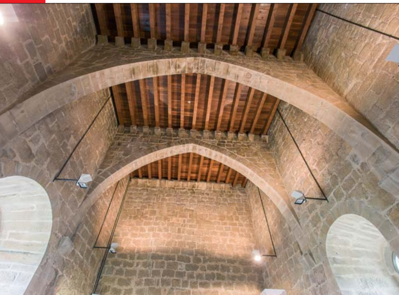
La arquitectura de la torre de Navardún es magnífica.
