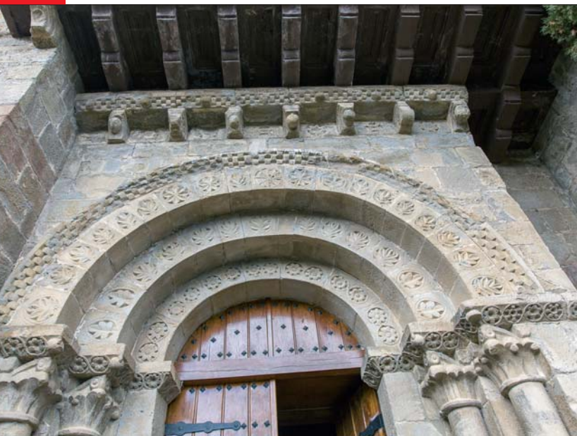
Portada de la iglesia de Navardún en la que destaca la decoración de palmetas y el ajedrezado jaqués.
