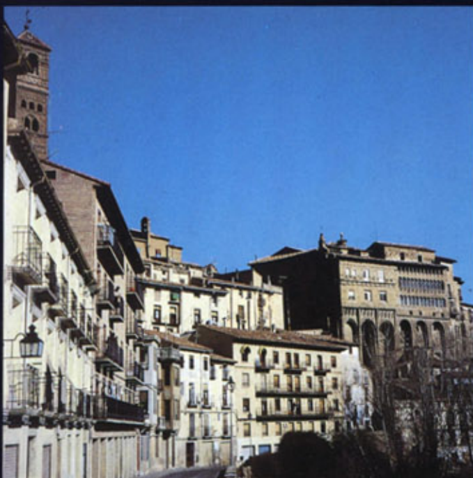
Calle de los Fueros de Aragón. Una panorámica sobre el valle del Queiles, eje de la vida de la actual Tarazona.
