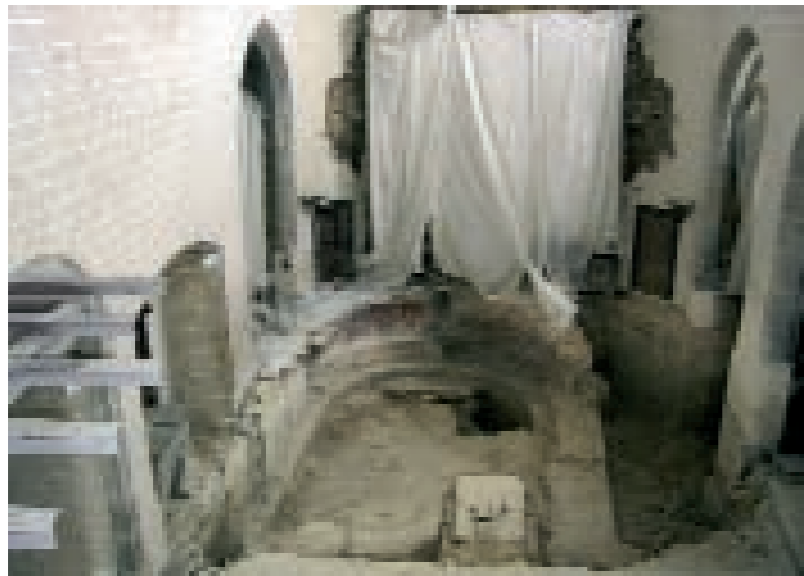
Escavación de la cripta románica de San Martín de Biel
