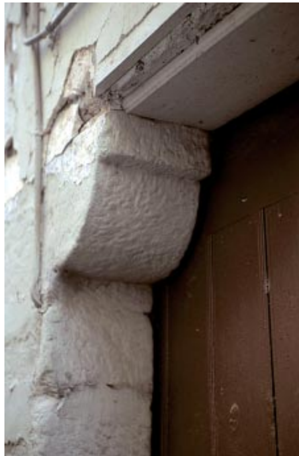
Zapata de una vivienda de la calle Trinidad. Judería de Alcañiz.
