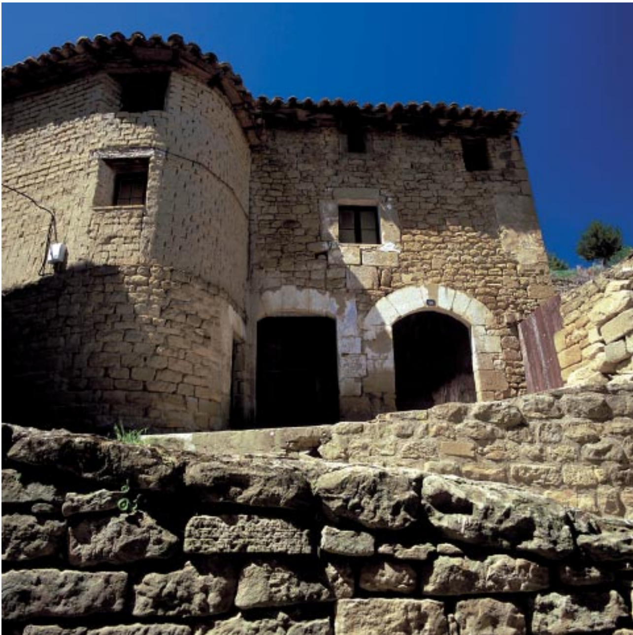
Edificio en sillar y adobe. Calle Barrionuevo. Judería de Uncastillo.
