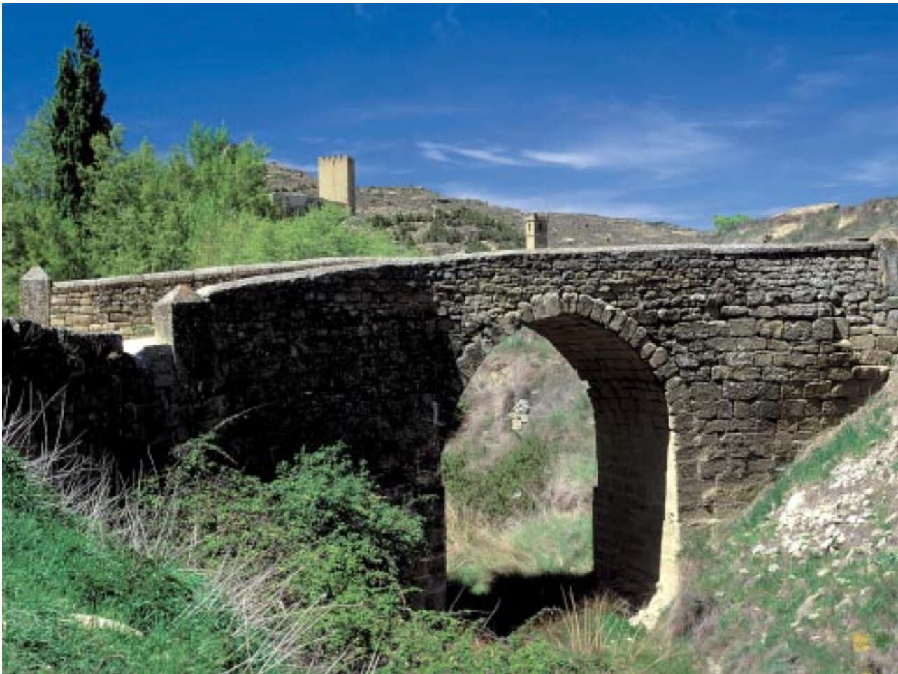
Puente de los judíos. Acceso a la necrópolis de Uncastillo.
