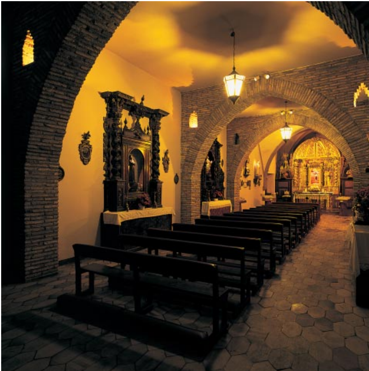
Ermita del Santo Cristo de Santiago, cuyo interior conserva los arcos fajones y la traza de la antigua sinagoga.
